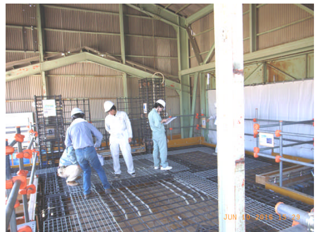
【配筋検査実習の様子】
