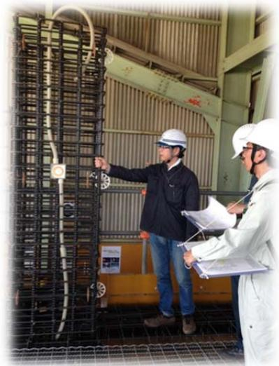
配筋検査は、2班に分かれ、主にかぶり厚や定着長さ、ガス圧接位置など各自が気付いた問題点を指摘し、講師から補足説明を受けながら各部位を見て回りました。また、配筋の不具合のほか、鉄筋が混雑している柱梁接合部や、鉄筋同士が干渉して設計通りの配筋ができない部分をみて、改めて「機械式定着工法の有用性」、「設計上の問題点」を実感しました。
